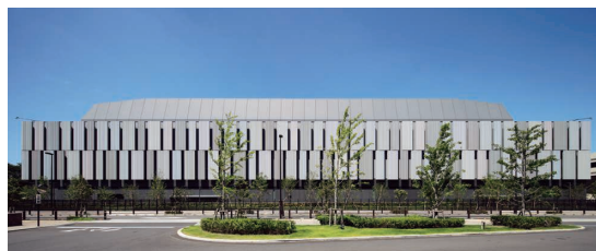
西東京データセンター
