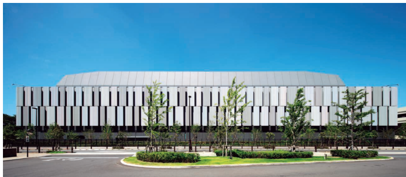
西東京データセンター
