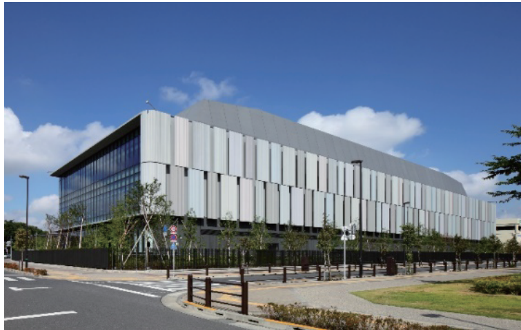
西東京データセンター 1号棟
