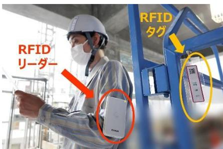
RFID リーダーが RFID タグを自動的に読み取っている様子
