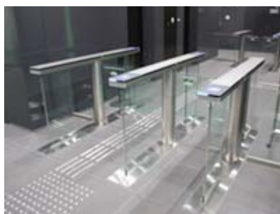
港南事業所のフラPPERゲート
