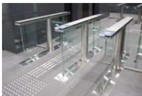
港南事業所のフラッパーゲート
