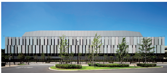
西東京データセンター
