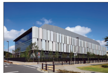
西東京データセンター
